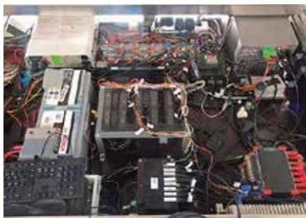
Die Mess- und Steuerungstechnik im Versuchsträger
